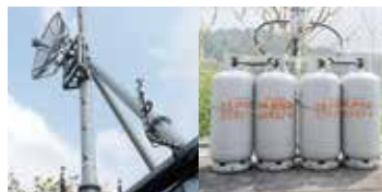
3つの基地局に設置されています
