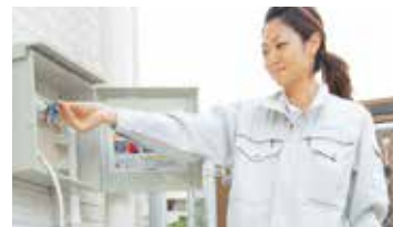
供給ボックスは2箇所に設置されています
